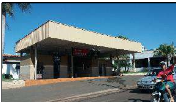
Figura 17: Vista Terminal Rodoviário Sandovalina
